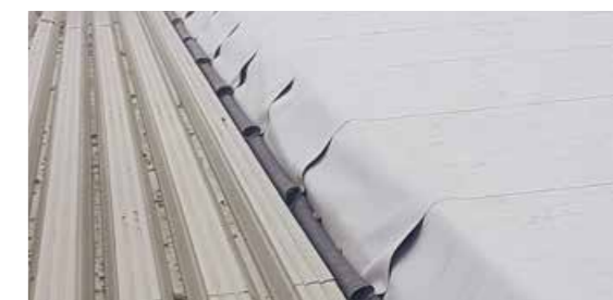
Izvedba in zaščita izolacije, t. i. dnevni zaključki
