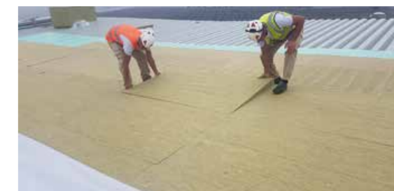
Vgrajevanje strešnih plošč
