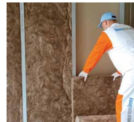
Predelne stene razdelijo prostor na manjše enote, poleg vizualne in fizične ločitve prostorov pa mora biti preprečen tudi prehod zvoka skozi steno. Še zlasti je to pomembno pri lahkih suhomontažnih predelnih stenah. Predelne stene z vgrajenimi izolacijskimi materiali KNAUF INSULATION omogočijo, da vsak prostor v objektu zaživi po svoje, hrup v sosednjih prostorih pa postane nemoteč. Hkrati se lahko zmanjša tudi poraba energije v objektu.
