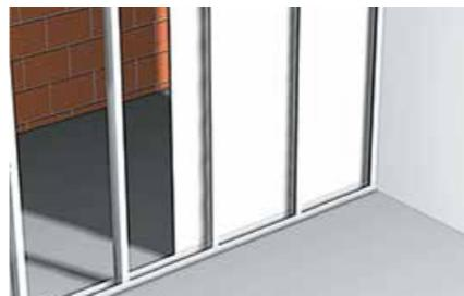
**1** Izdelamo nosilno konstrukcijo predelne stene, ki jo pritrdimo v tla, strop in stene. Stike zatesnimo s tesnilnim trakom. Mavčno-kartonske plošče na eni strani pritrdimo na nosilno konstrukcijo.
