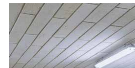
Lamela se na notranje stropne samo lepi in ne potrebuje mehanskega pritrjevanja. Zaključna obdelava ni potrebna.
