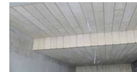
V primeru neravne površine stropa lamela omogoči optično izravnavo površine zaradi posebnega roba po obodu.
